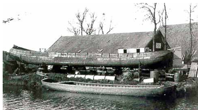
Een skûtsje in aanbouw, met ervoor, in het water, een praam
